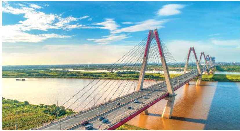
Hình 14. Cầu Nhật Tân (Hà Nội) được xây dựng trong thời kì đổi mới
