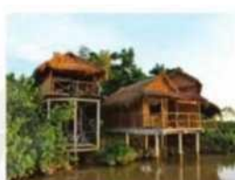
Hình 1.6. Nhà trên cọc (nhà trên kênh, rạch) ở Đồng bằng sông Cửu Long
