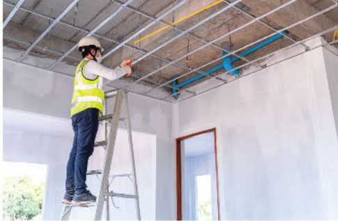
Hình 7.1. thợ lắp điện cho toà nhà
