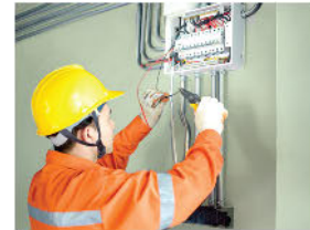
d) Lắp đặt mạng điện trong nhà
