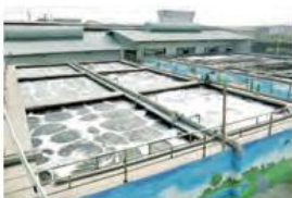
Xử lý nước thải
