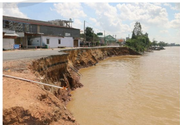
Hình 1.4. Sạt lở đất ở quốc lộ 91 đoạn đi qua xã Bình Mỹ, huyện Châu Phú, tỉnh An Giang năm 2019
