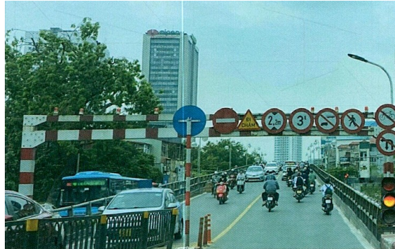
Hình 7.82. Tại đây một số cầu vượt ta có thể bắt gặp khung không chế chiều cao.
