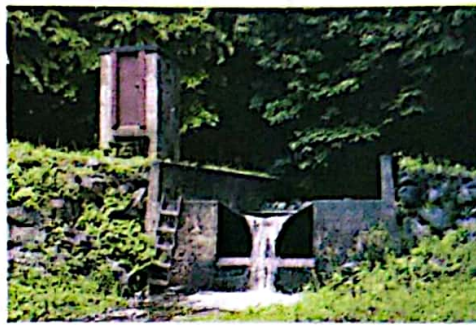
(a) Các đập bằng bê tông và đập tràn hình chữ V chắn ngang dòng kênh ở cuối của lưu vực sông, giúp cho các nhà khoa học có thể giám sát dòng chất dinh dưỡng và nước chảy ra khỏi hệ sinh thái.
