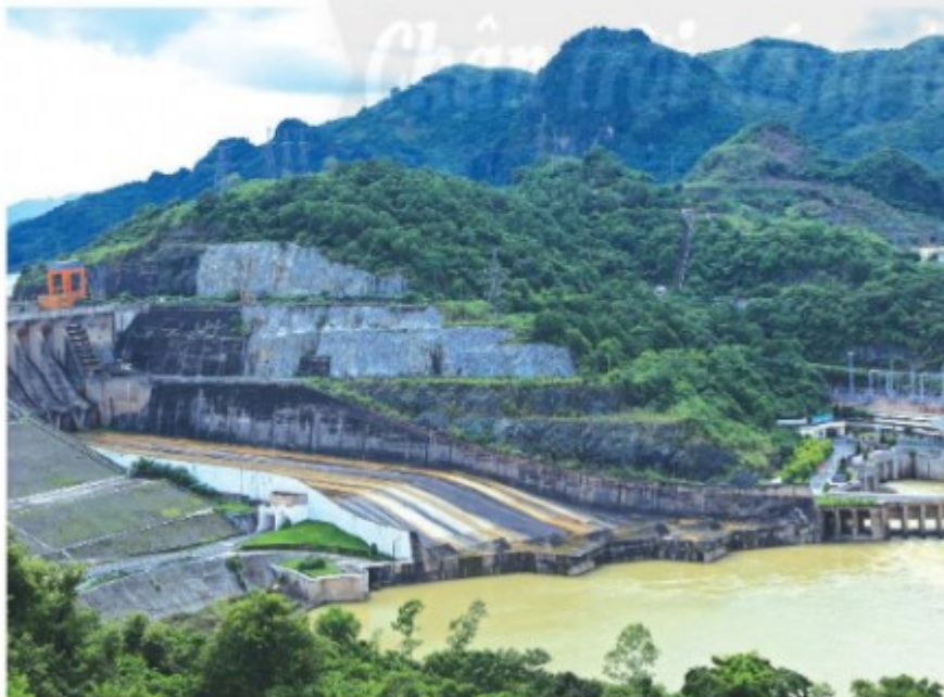
c) Nhà máy thủy điện (Hoà Bình)
