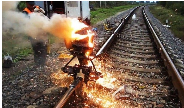
Hình. Phản ứng nhiệt nhôm hàn đường ray tàu
