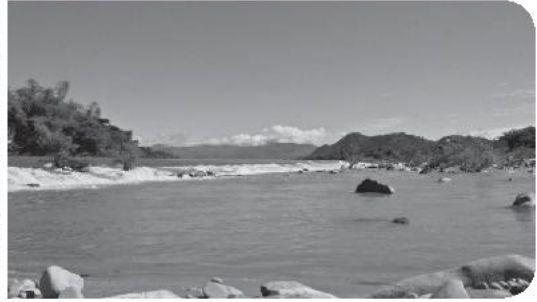
Hình 16.2. Đập Nha Trinh (Ninh Thuận)
