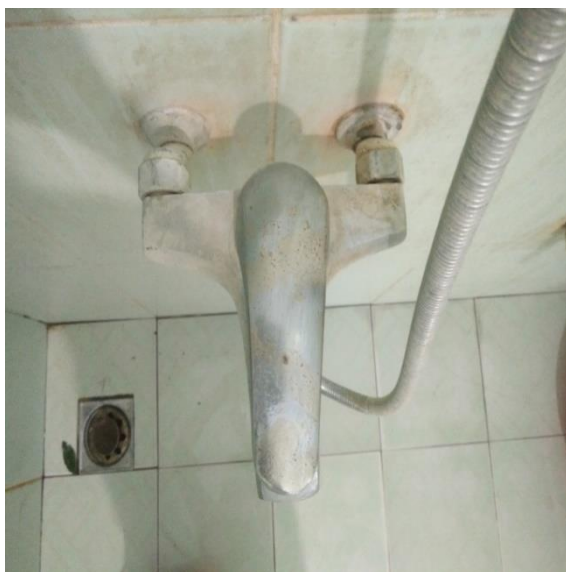
Vòi nước, ấm đun nước sử dụng lâu ngày bị bám cặn
