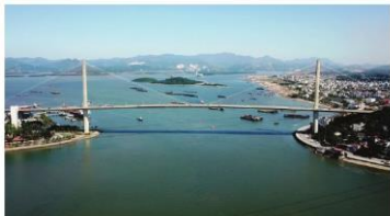
Cầu Bãi Cháy (Nguồn: https://vnexpress.net )
