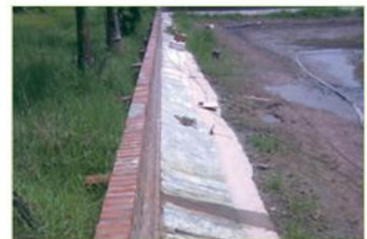
d) Ao nổi, kê bờ
